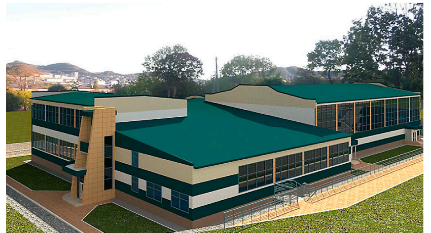
Здание каркасного типа. Каркас металлический. Крыша-кровельные сэндвич-панели. Наружная отделка-стеновые сэндвич-панели в сочетании с облицовкой оградящих конструкций металлическими фасадными кассетами. Заполнение проёмов-витражи из алюминиевого профиля.
