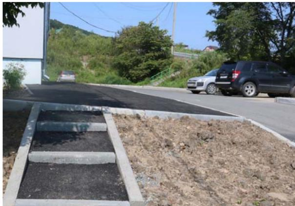
подтопление и размыв дорожного полотна. Для этого были выкопаны специальные каналы и обустроены дренажные каналы, что уже дало положительный результат: во время последнего ливня выхода воды на поверхность проезжей части не происходило. После этого рабочие приступили к укладке асфальта. Также в этом районе заменят бордюрный камень и обустроят дополнительный тротуар от детского сада №7.
